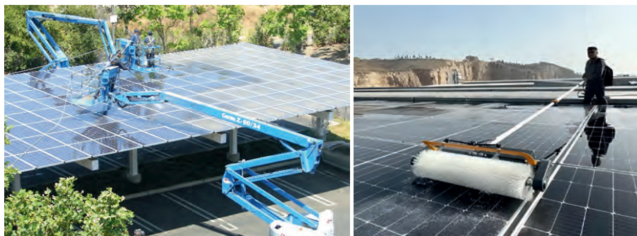
3.7-расм. Қуёш панелларини тозалаш жараёни
