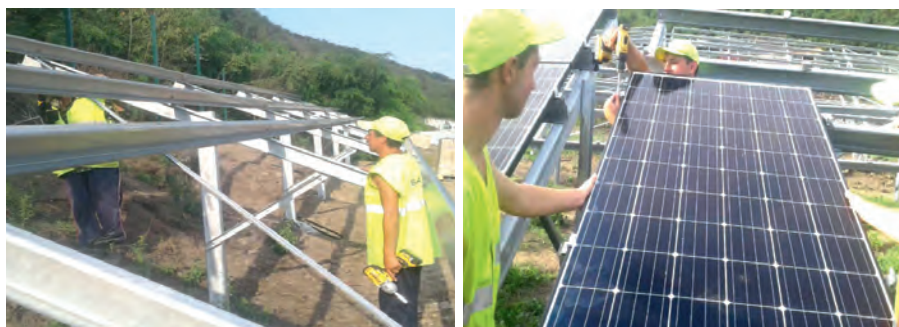
3.5-расм. Қуёш фотоэлектрик станцияларини монтаж қилиниши
